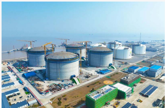
舟山接收站三期施工现场鸟瞰图
